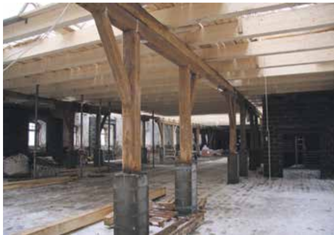
Ehitusjärgus hoone sisevaade.
